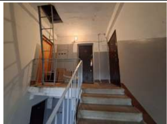
5.stāva kāpņu telpa
